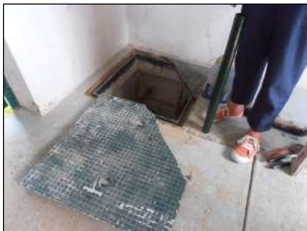
Figure 4 : réservations présentes sur le radier du bâtiment
