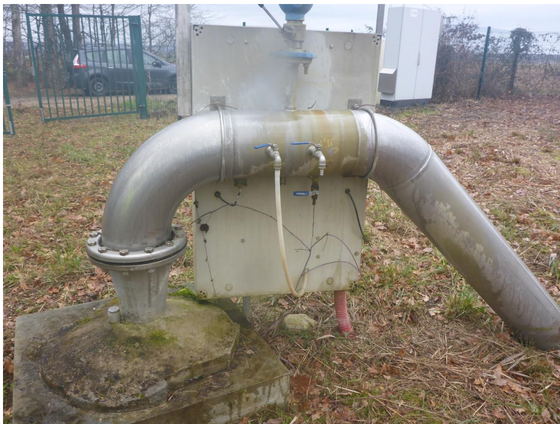
Tête du forage de Nainglet et en arrière-plan le portail d'accès au site
