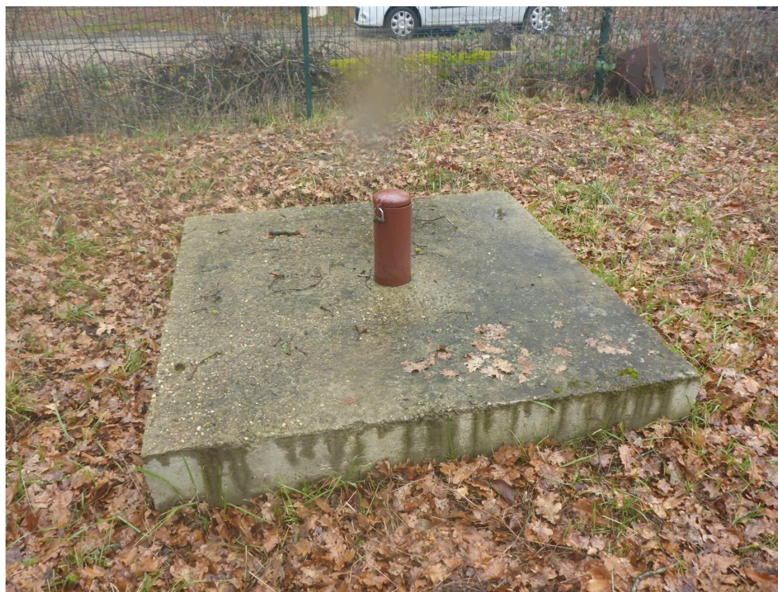
Piézomètre de la nappe phréatique situé à l'angle Ouest du site
