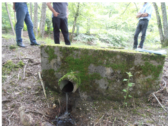
Figure 7 : trop-plein et départ de l'étang annexé à l'étang de la Princesse
