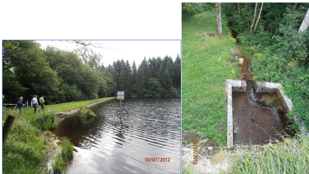
Figure 6 : la digue (à gauche) et le trop-plein (à droite)
