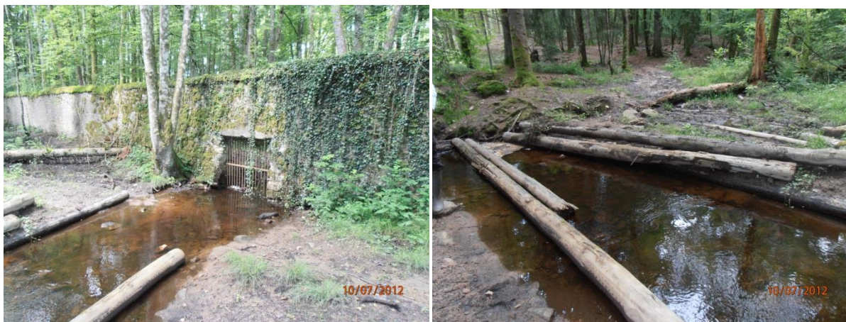
Figure 7 : passage à gué sur le ruisseau de la Toison en amont de l'étang des Cloix
