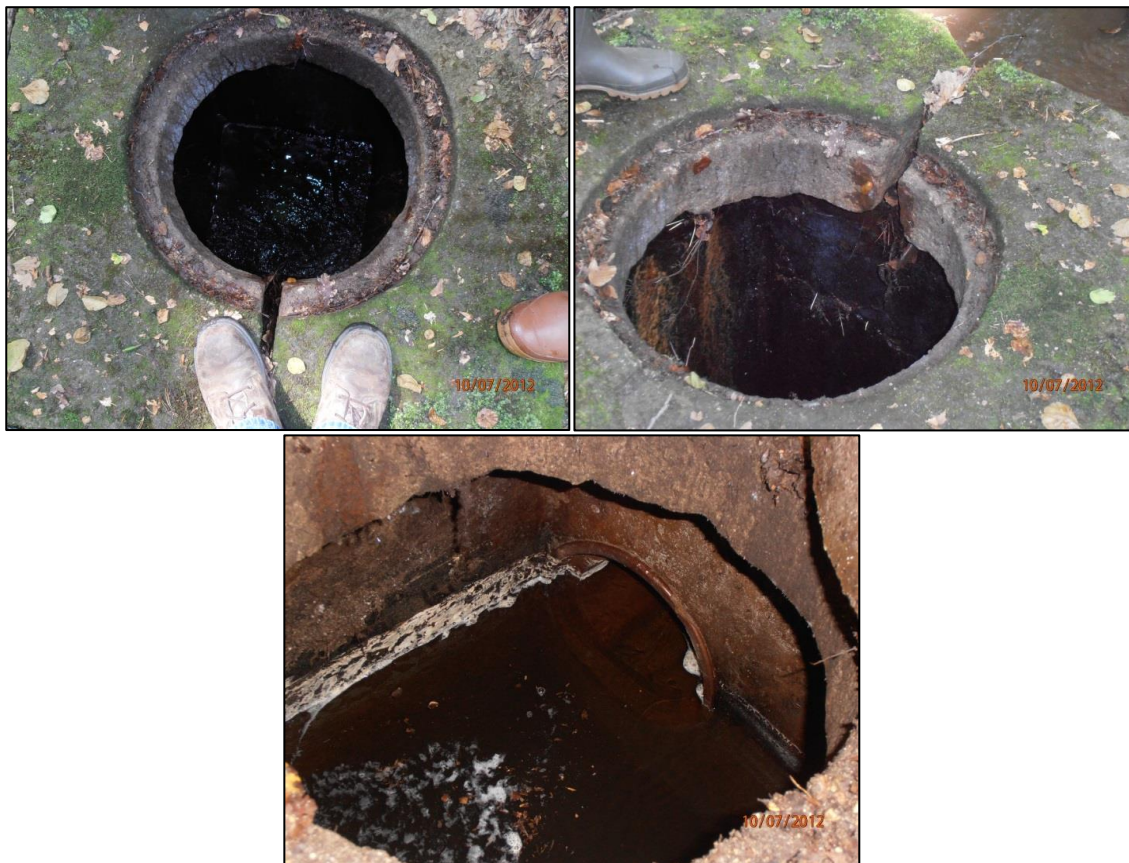
Figure 5 : l'ouvrage de réception FE1
