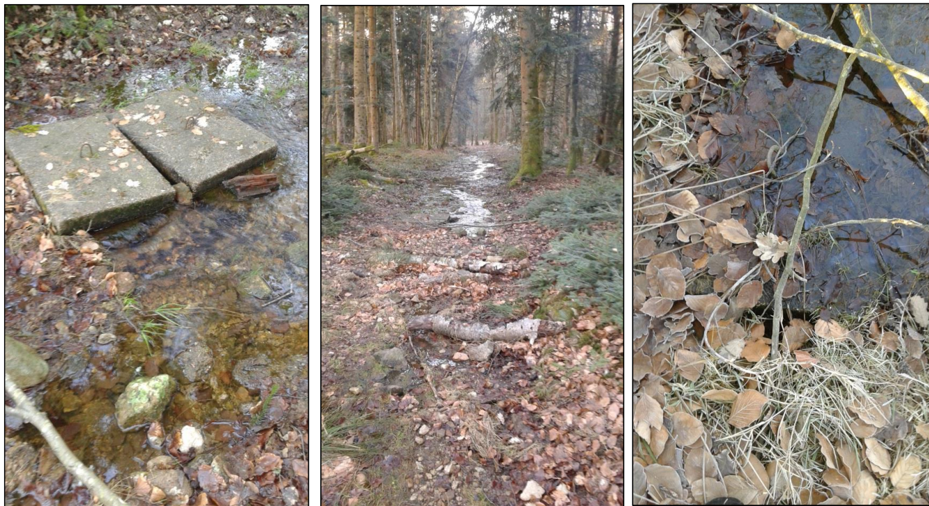
Figure 13 : les regards situés à l'aval de FE4
