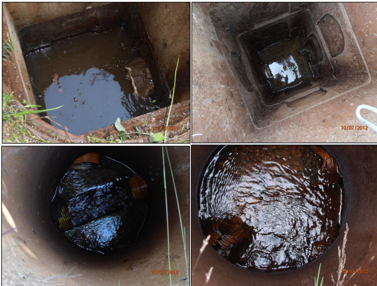
Figure 6 : les regards FE16 (en charge), FE15 (rectangulaire), Fe14 et FE9 – avant travaux
