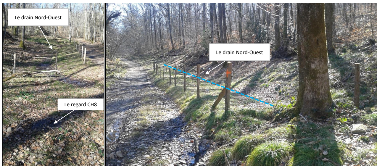
Figure 7 : captage amont CH8 et drains associés – après travaux
