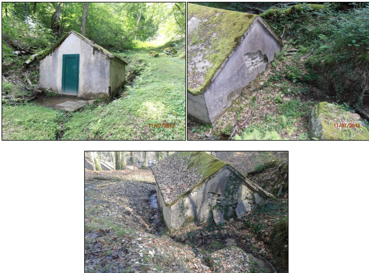
Figure 5 : l'ouvrage de réunion CH CABANE – cliché du bas pris le 17/02/2019
