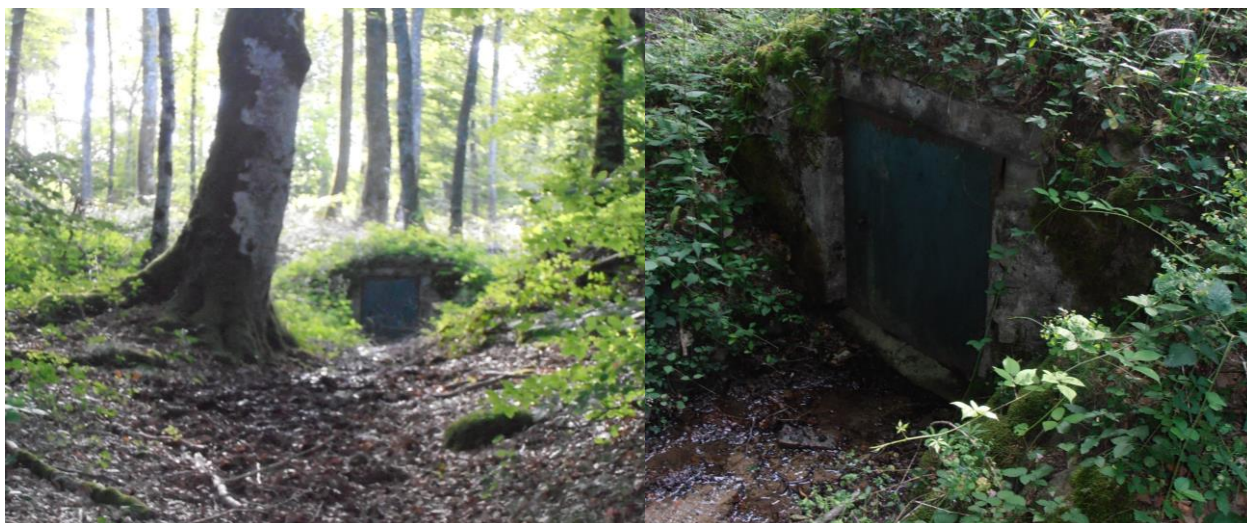
Figure 5 : le captage des Luineries sud vu de l'extérieur
