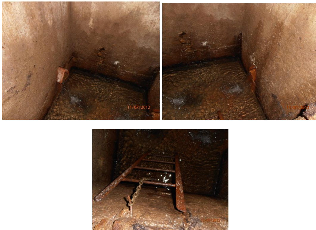
Figure 6 : le captage des Luineries sud vu de l'intérieur
