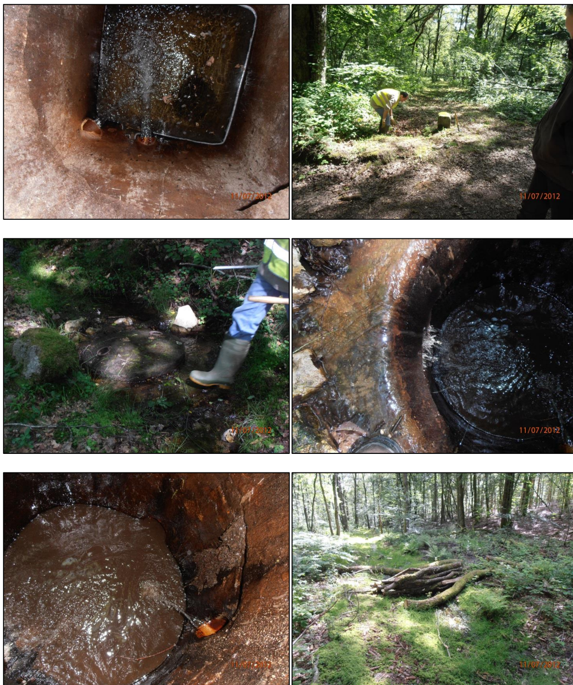
Figure 5 : les drains et les regards d'aval en amont de la zone de captage de Montmain avant les travaux
