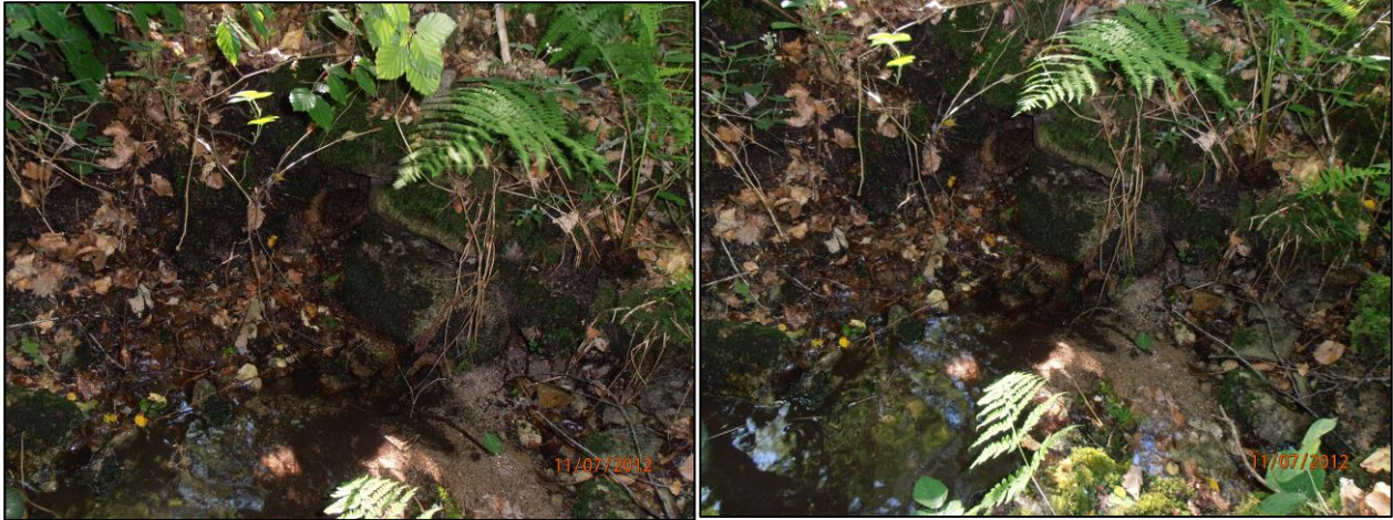
Figure 7 : trop-plein/vidange du captage de Source Chaude
