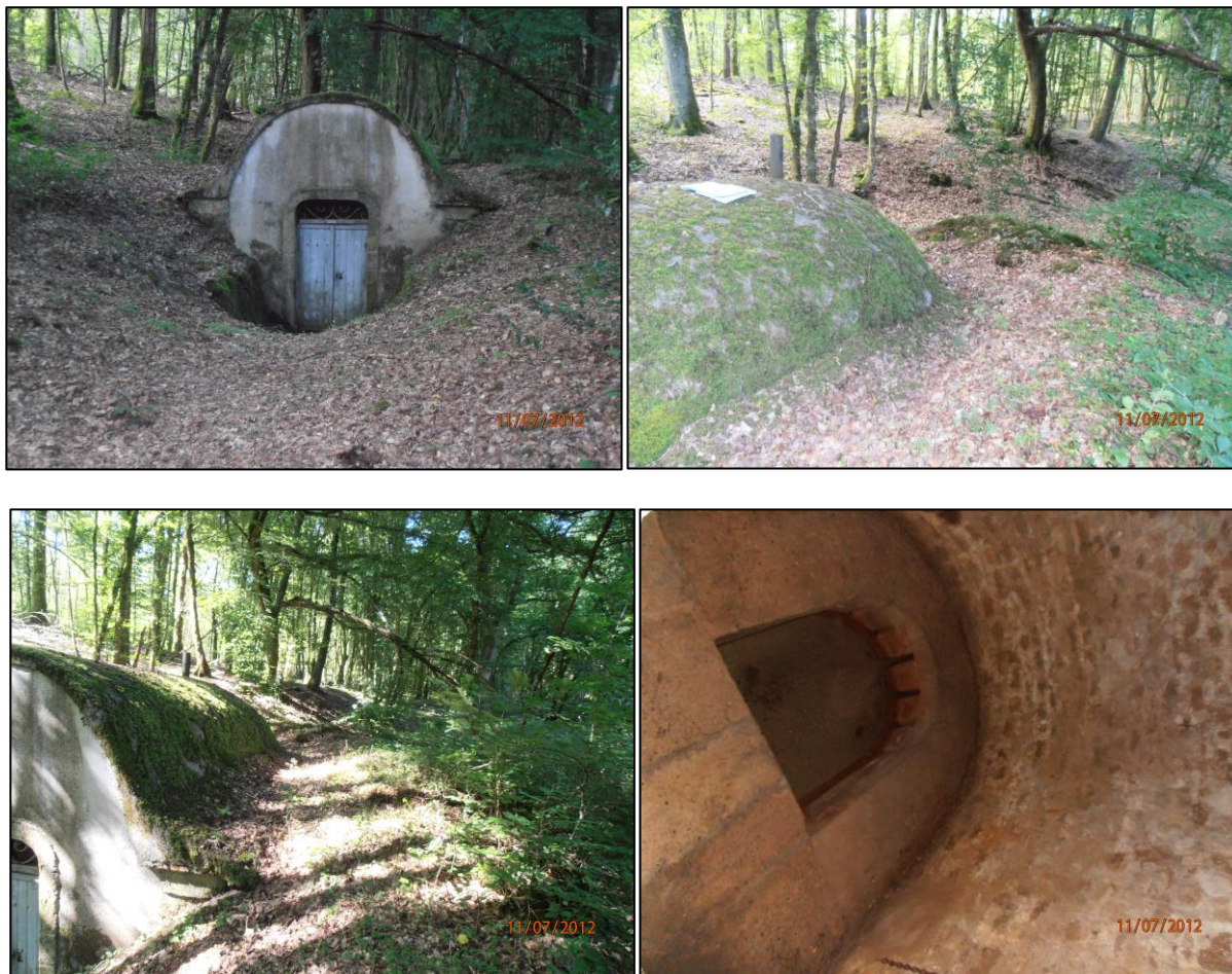
Figure 5 : vues extérieures et intérieures du captage de Source Chaude
