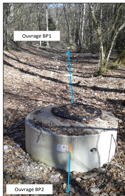
BP2 et la direction du drain vers le nouvel ouvrage BP1
