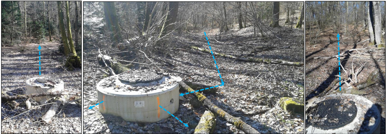
Figure 8 : le nouvel ouvrage BP1 et les deux directions de drain du captage de Belle-Place après réhabilitation
