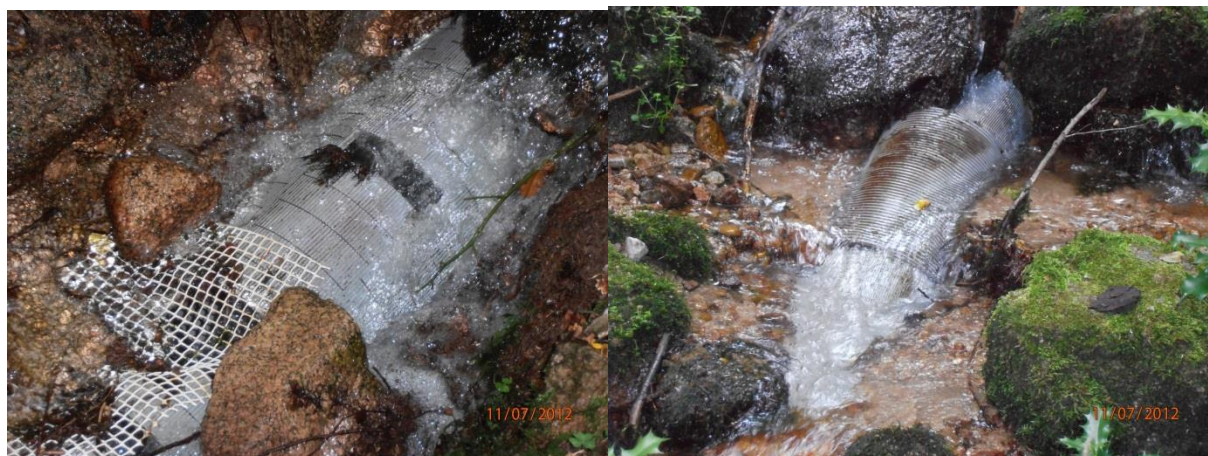
Figure 6 : morceau de drain repéré dans le cours du ruisseau du Maquet avant travaux
