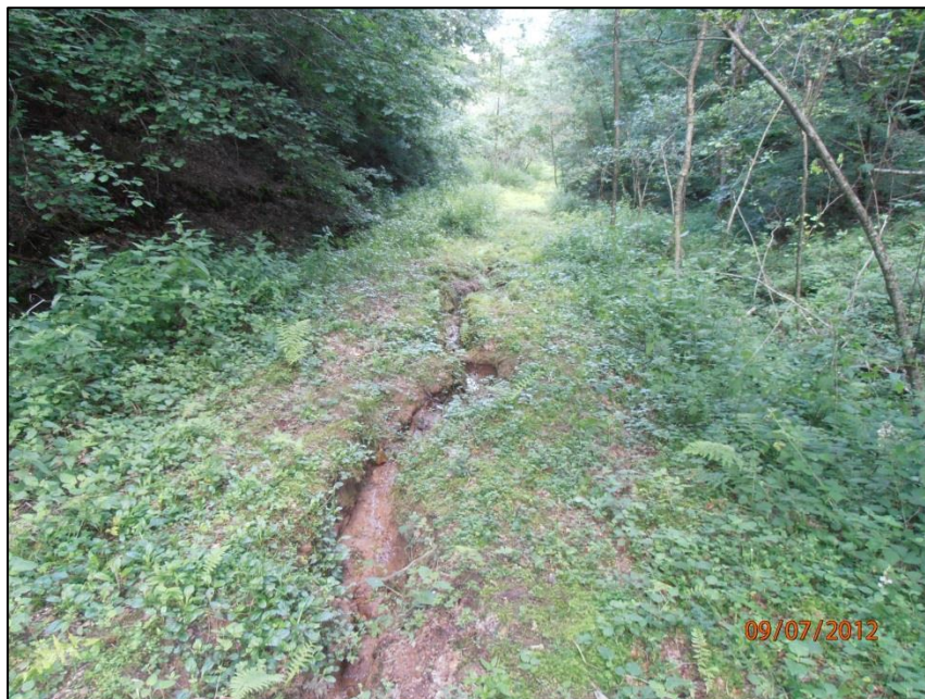
Figure 9 : ornières au droit de la trouée ou passe la galerie entre les regards SCL CPTGE et SCL1
