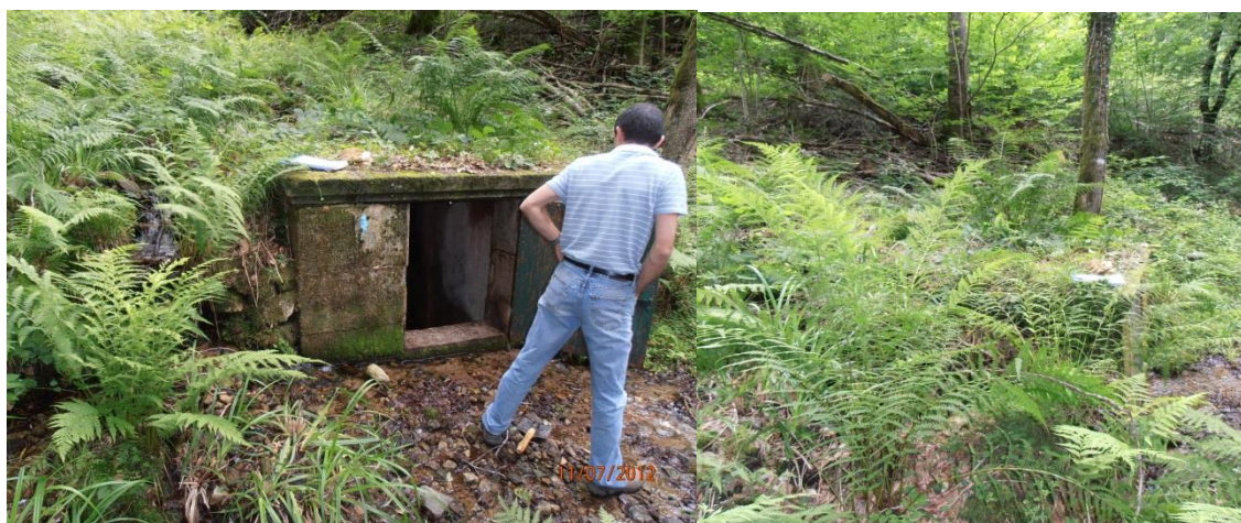
Figure 6 : la chambre de réception des eaux du captage du Pouilloux vue de l'extérieur
