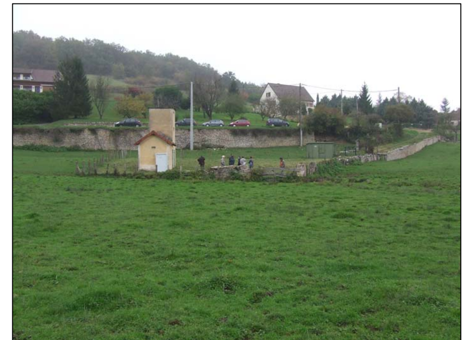
Vue d'ensemble du captage et de la station de pompage
