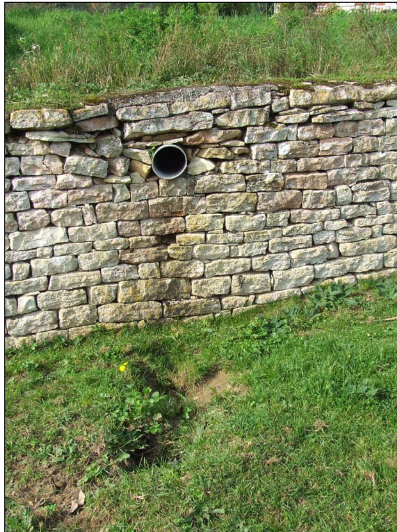
Rejet d'eaux pluviales de la route, sous le chemin de desserte du captage
