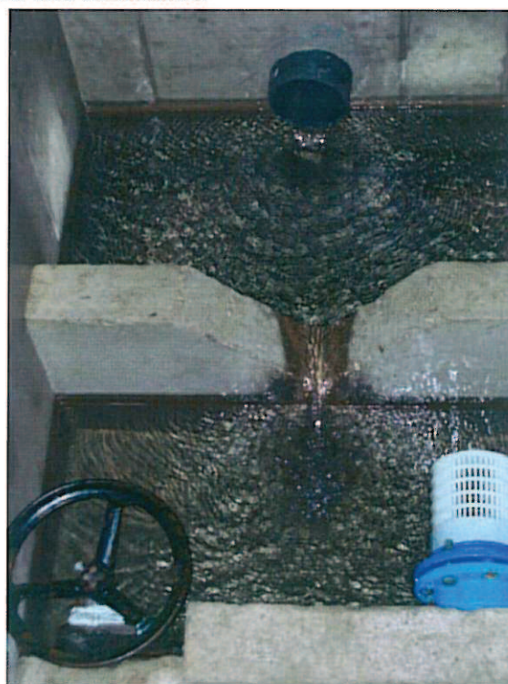
Intérieur de l'ouvrage
