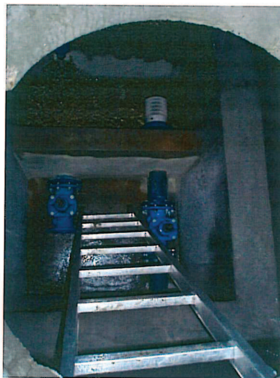
Intérieur de l'ouvrage
