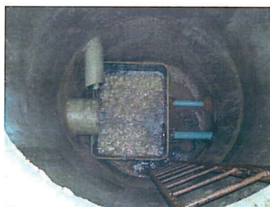
Intérieur de l'ouvrage de Fontaine Froide Haut
