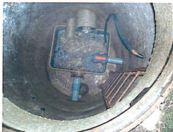
Intérieur de l'ouvrage de Fontaine Froide Bas
