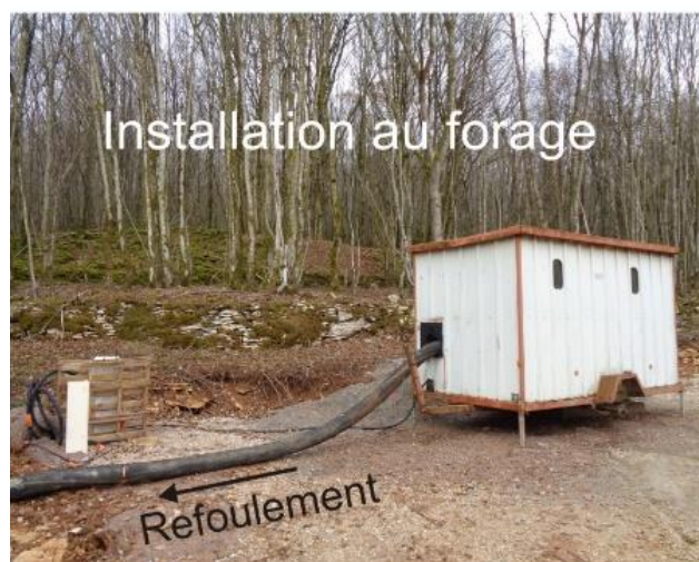
Plateforme créé autour du forage avec Algeco posé sur le forage
