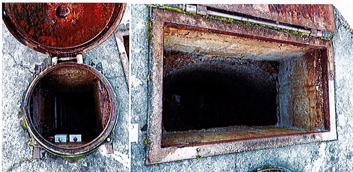
Figure 6 : Capot d'ouverture et trappe d'accès aux pompes
