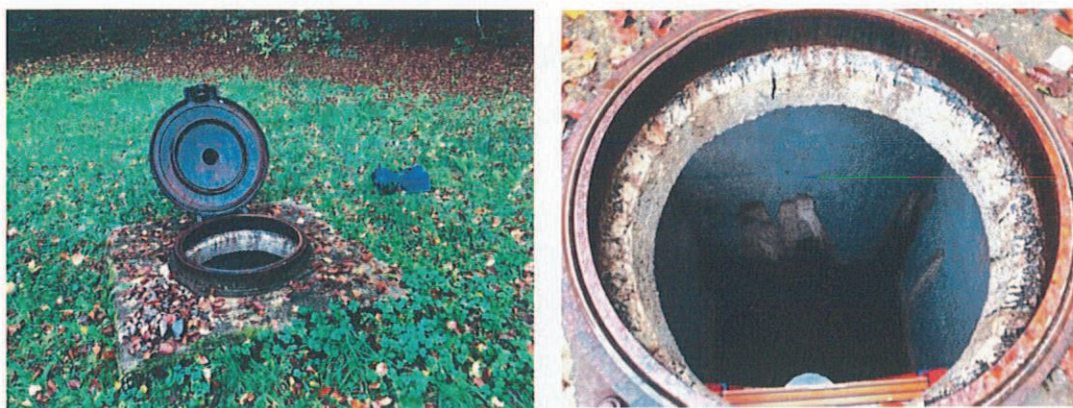
Figure 4 : Vue du captage de la Corre
