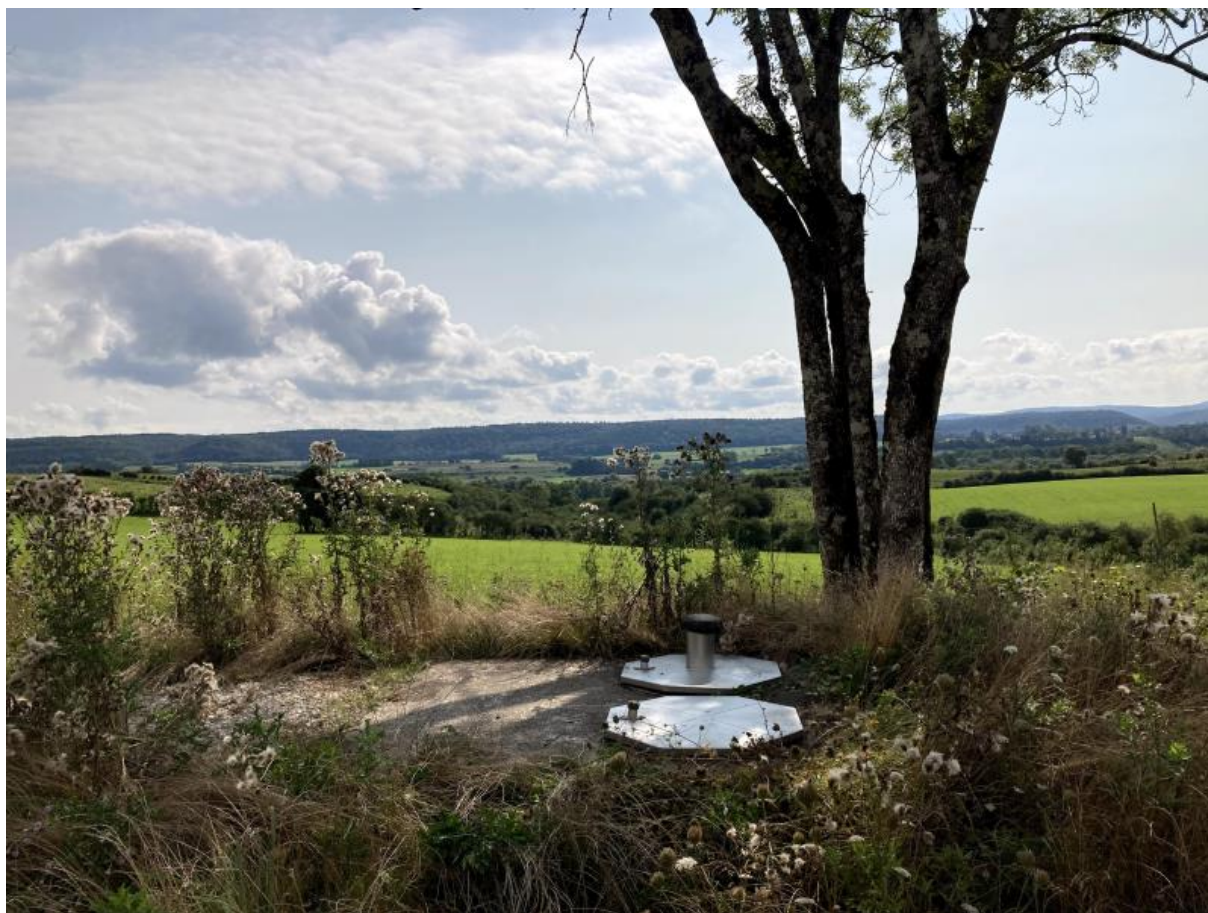
Vue de la chambre du forage 2
