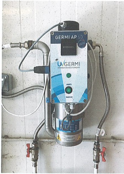
Photographie 1 : lampe GERMI AP 60 UV et réservoir tampon
