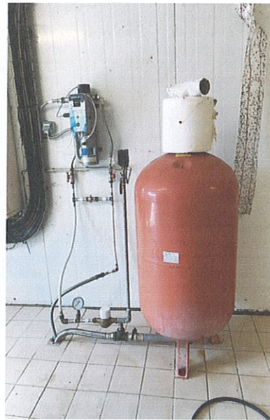
Photographie 1 : lampe GERMI AP 60 UV et réservoir tampon
