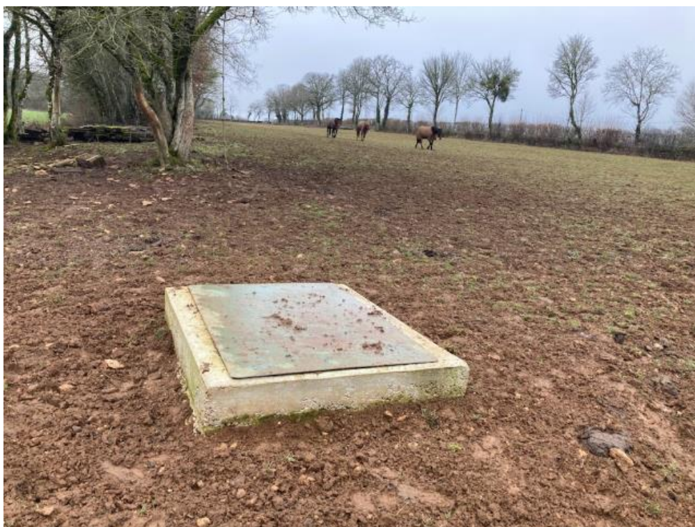
Vue de la chambre abritant la tête de forage
