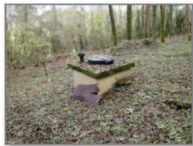
Environnement immédiat du captage
