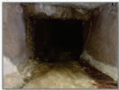
Vue du trop plein
