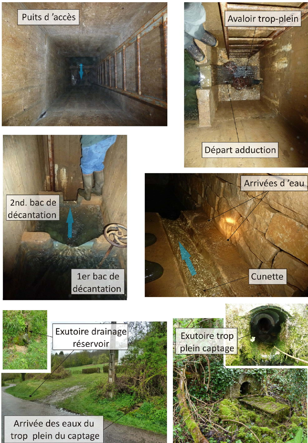
Caractéristiques techniques du captage.
