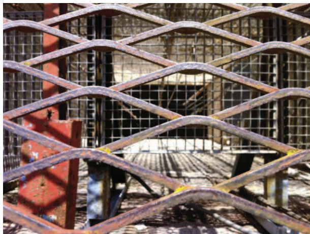
prise d'eau vue depuis la digue
