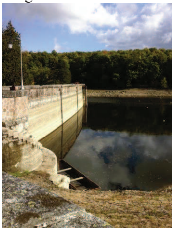
Position de la prise d'eau actuelle derrière la digue
