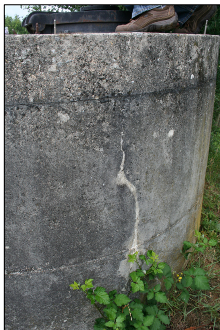
Clichés 3 et 4 : la tête de puits – présence de traces de salpêtre
