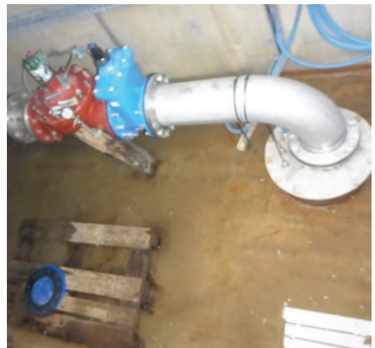
Tête du F2 après aménagement de la fermeture de tête étanche
