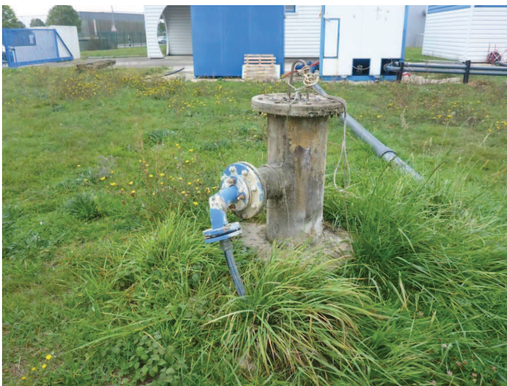
Tête du forage de reconnaissance F1
