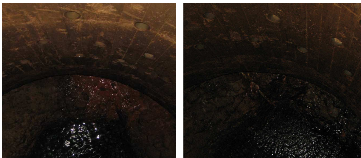
Figure 2 : Clichés de l'intérieur du puits de Licey le 20 mai 2011
