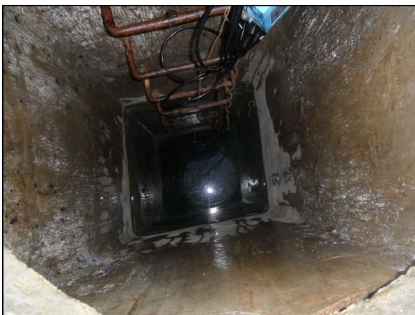
Clichés 9 et 10 : vue des parois humides à l'intérieur du captage
