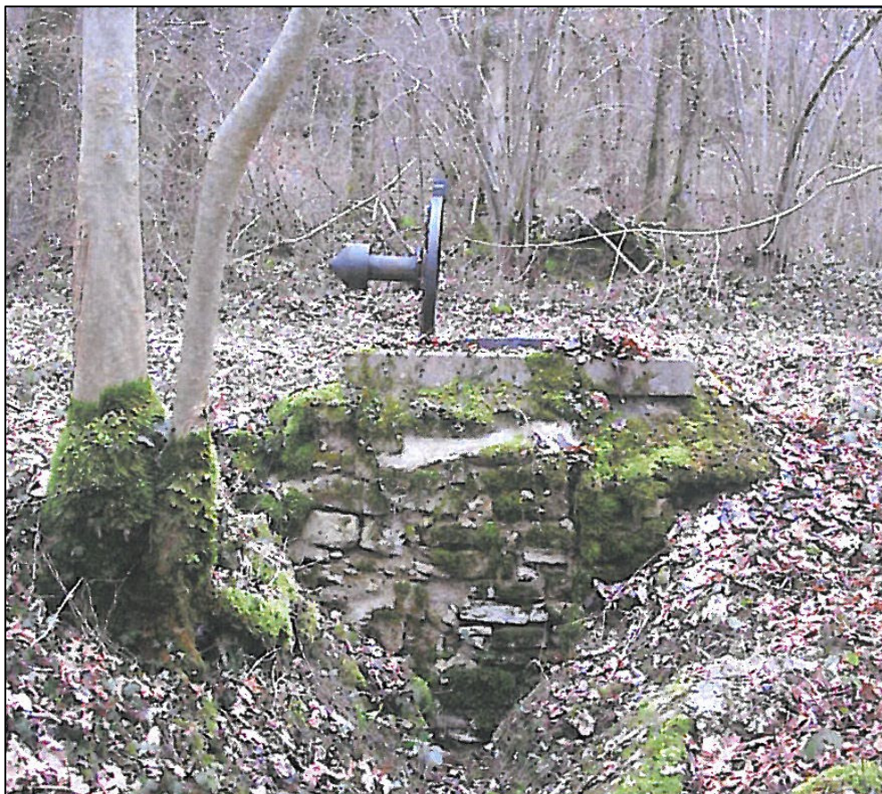
Cliché 3 : captage de la source de Fontaine du Pautat (source : étude CPGF HORIZON)
