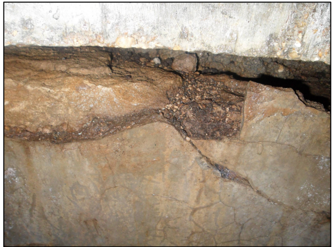
Clichés 7 et 8 : défauts d'étanchéité externe et interne entre la dalle de couverture et l'édifice
