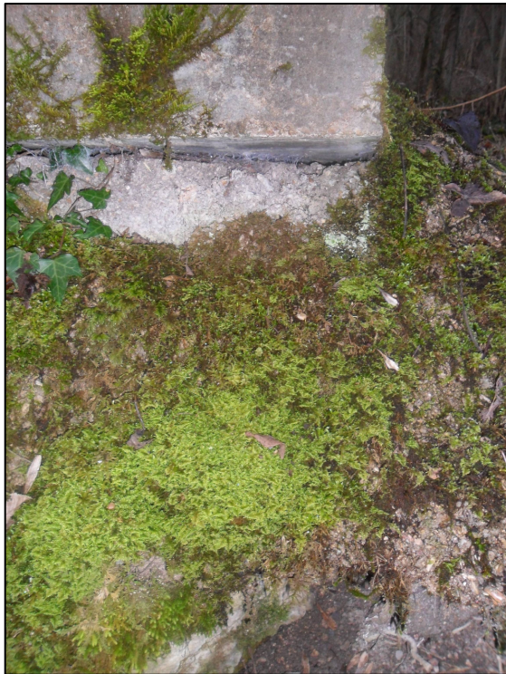
Clichés 7 et 8 : défauts d'étanchéité externe et interne entre la dalle de couverture et l'édifice
