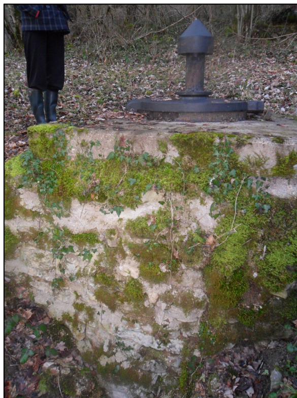
Cliché 5 : ouvrage bâti en pierre
