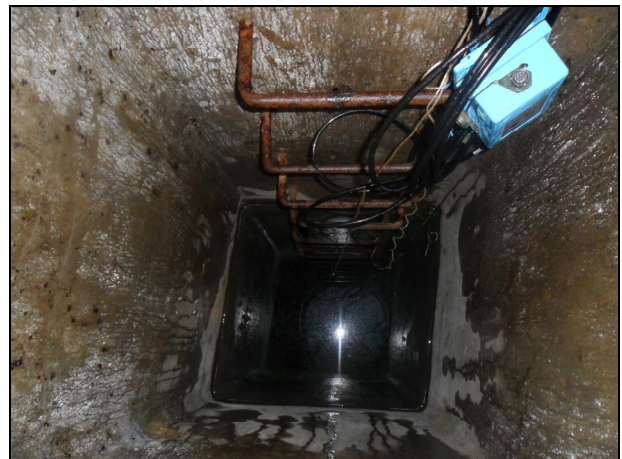
Clichés 9 et 10 : vue des parois humides à l'intérieur du captage
