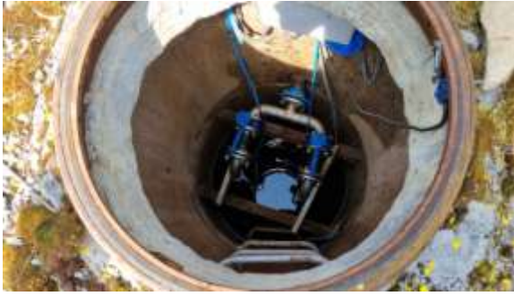
Le puits et ses deux pompes
