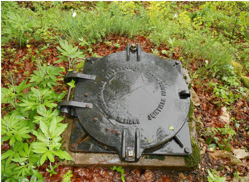
Photo 4: vue supérieure du capot de fermeture en fonte
