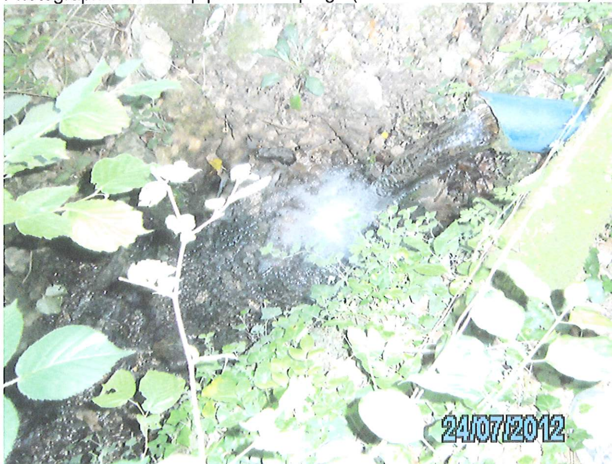
Photographie 2 : le trop plein du captage (environ 2 L/s le 24/07/2012)
