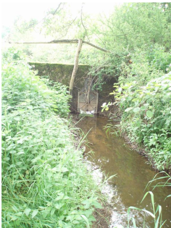
Réglage du niveau du Bief par une vanne (la vanne ne semble pas fonctionner souvent)
