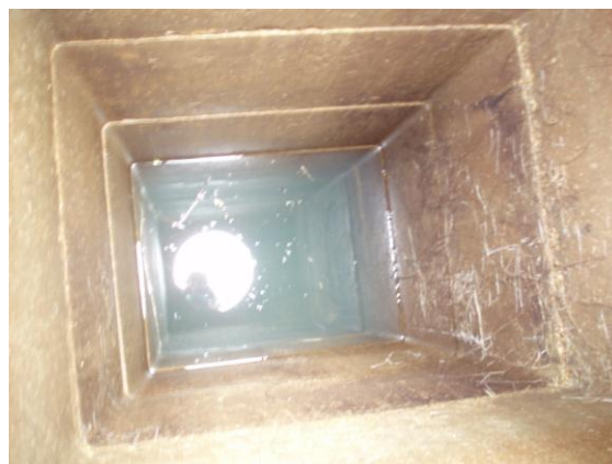
Regard du drain sur P4 non étanche avec éléments en béton disjoints
