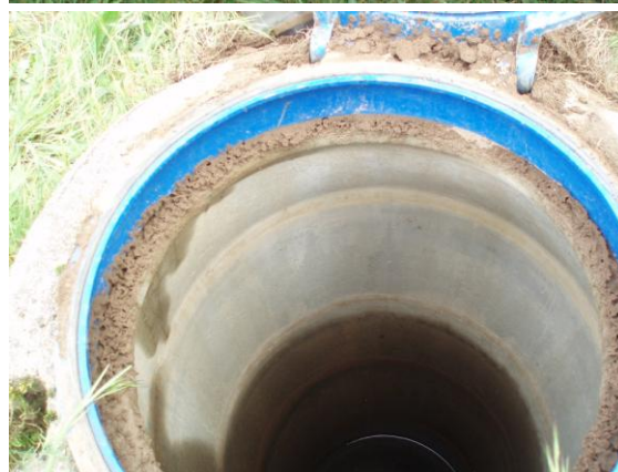
Regard du drain sur P4 non étanche (présence de terre et d'une fourmilière)
