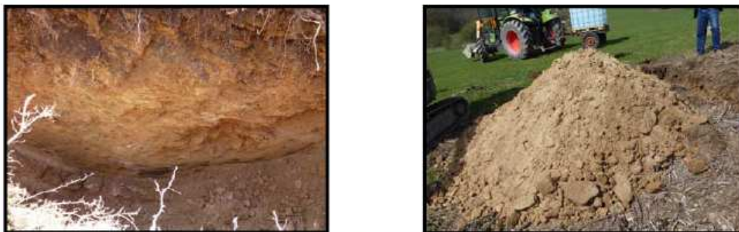
Figure 10 : Réalisation de la fouille à l'amont du captage Bas
