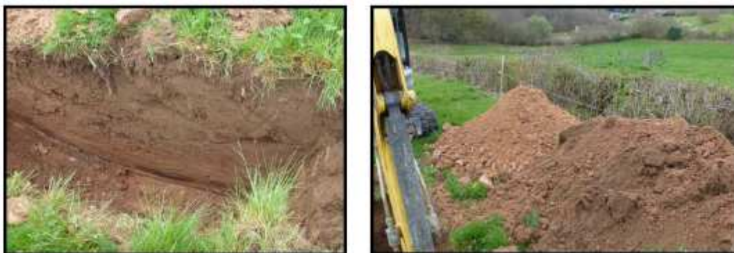
Figure 11 : Réalisation de la fouille à l'amont du captage Haut
