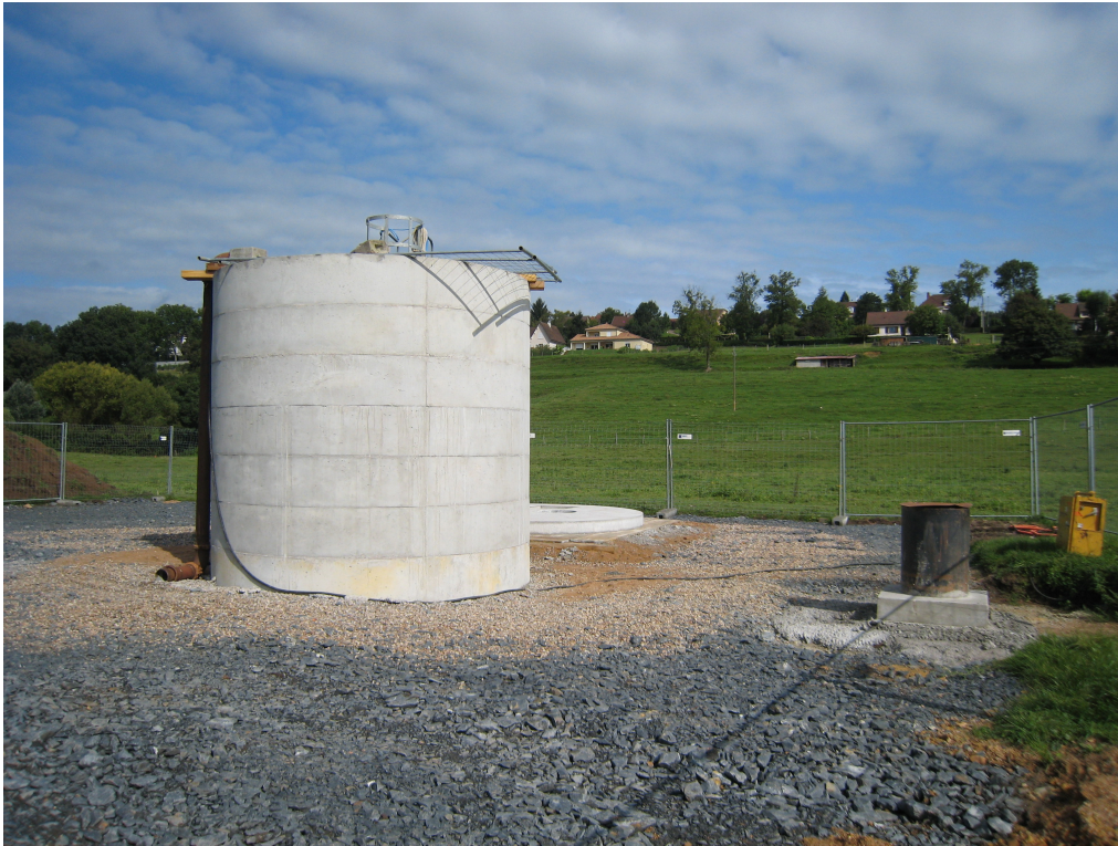
Photo n°1 : Photographie du puits de Romay et de son cuvelage en cours de finalisation, prise par l'hydrogéologue agréé lors de sa visite du site le 22 août 2007
