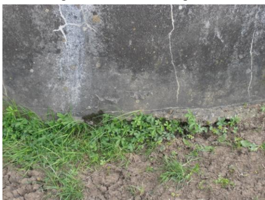
Fissures du ciment sur toute la hauteur de l'ouvrage et pénétration des eaux au pied
