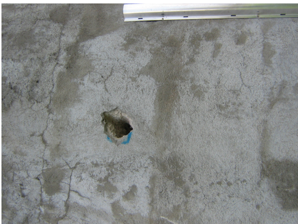
Cliché 1 : trou dans la paroi du puits
