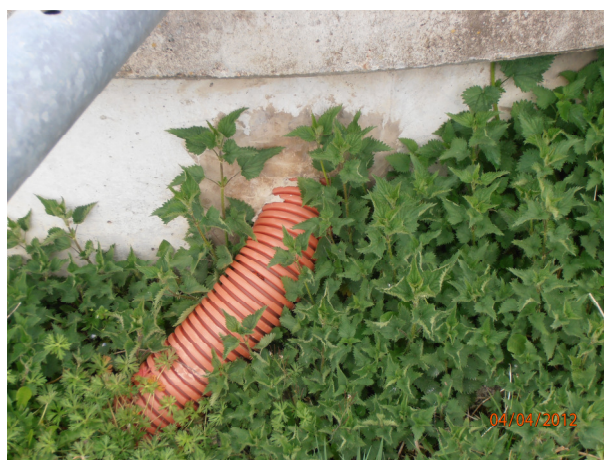
Cliché 10 : passage de la gaine d'alimentation électrique colmaté
