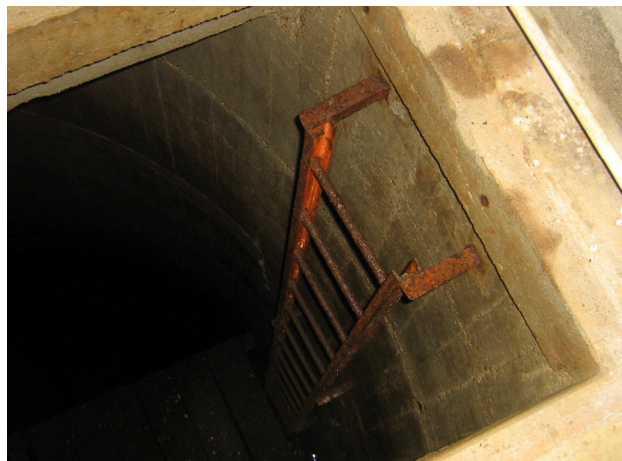
Cliché 2 : échelle interne d'accès au puits
