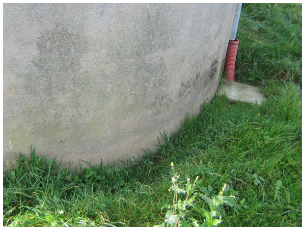
Cliché 4 : affouillement au pied du puits
