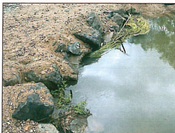
L'amont de la digue : buses colmatées par des végétaux et eau stagnante
