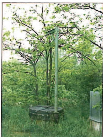
Le puits de pompage et l'exhaure de la réalimentation artificielle
