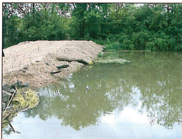
L'amont de la digue : buses colmatées par des végétaux et eau stagnante
