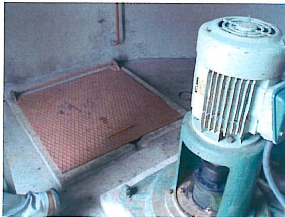
Intérieur du P3 avec le rebord béton entaillé
