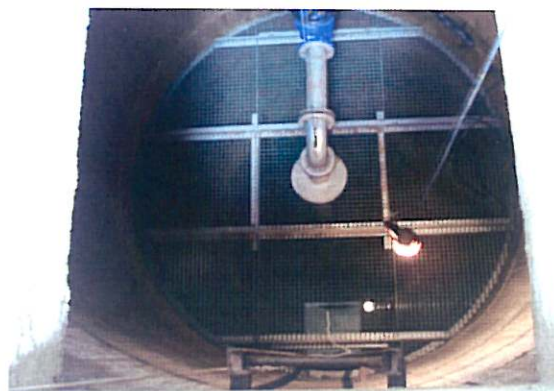
Une grille recouvre le puits P1
