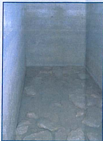
Photo N° 2 : Émergence de la source, eau légèrement trouble (fines)
