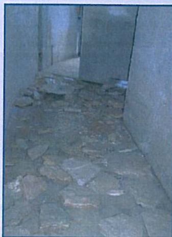
Photo N° 3 : Fond "pavé" de l'ouvrage bétonné.
