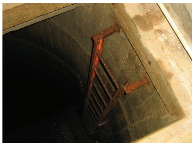
Cliché 2 : échelle interne d'accès au puits
