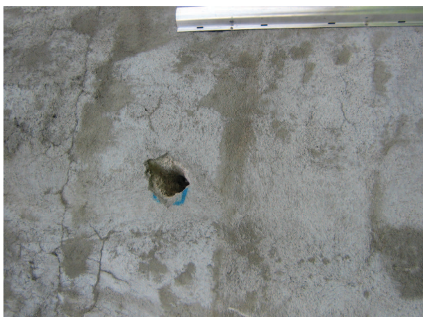
Cliché 1 : trou dans la paroi du puits
