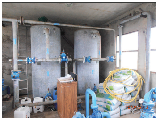
Clichés 9 à 11 : la pompe doseuse, les pompes de reprise, le stockage de neutralite
