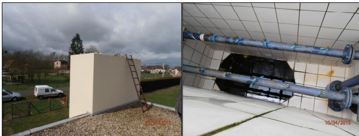
Clichés 12 et 13 : la bache d'aération située sur le toit de la station
