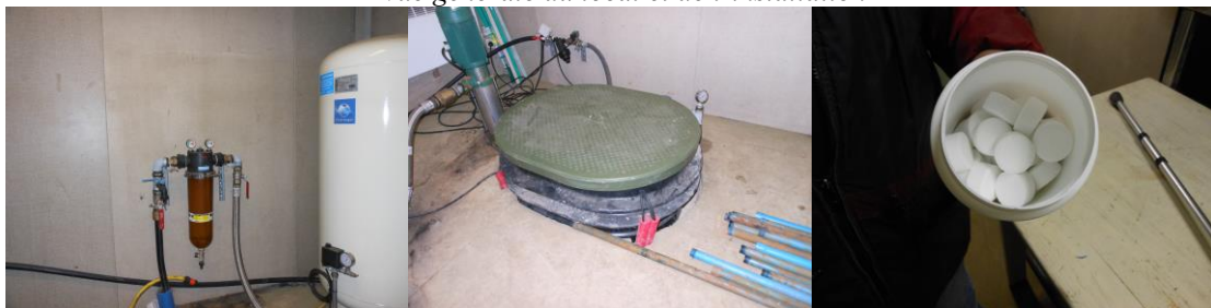
détails du système de filtration, de l'accès à la bâche et des pastilles de chlore utilisées
