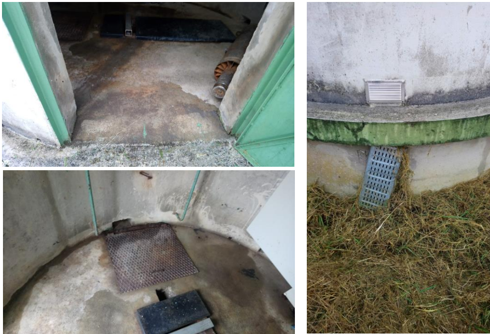
Figure 12 : Défauts d'étanchéité observés sur le puits 3
