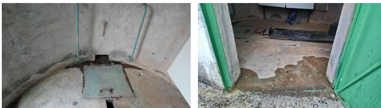
Figure 15 : Défauts d'étanchéité observés sur le puits 5
