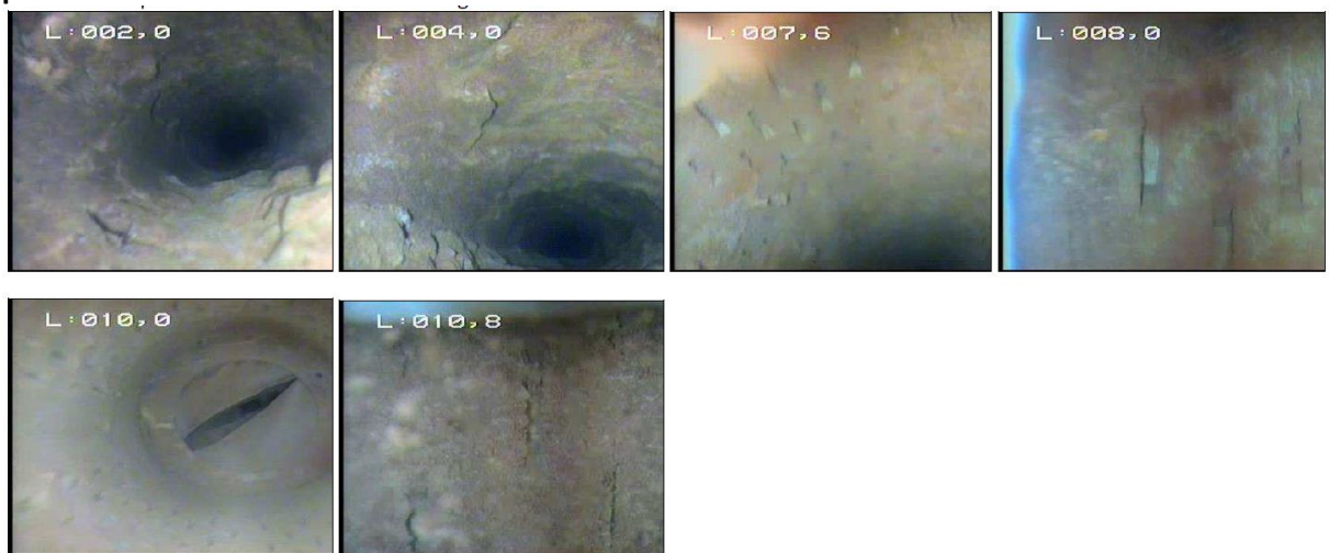
Figure 13 : Exemple de colmatage observé sur le drain n°4.
