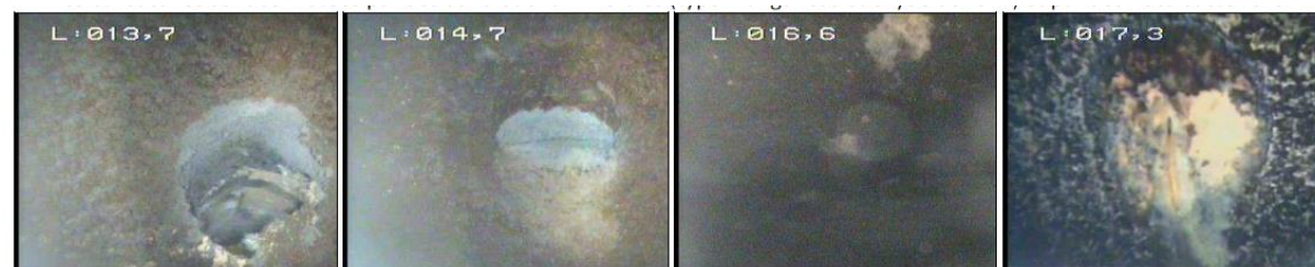
Figure 14 : Exemple de colmatage observé sur les barbacanes du puits 5.
