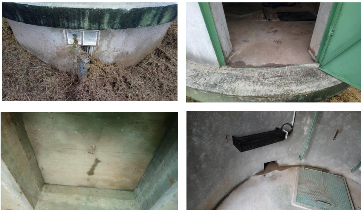
Figure 10 : Défauts d'étanchéité observés sur le puits 2
