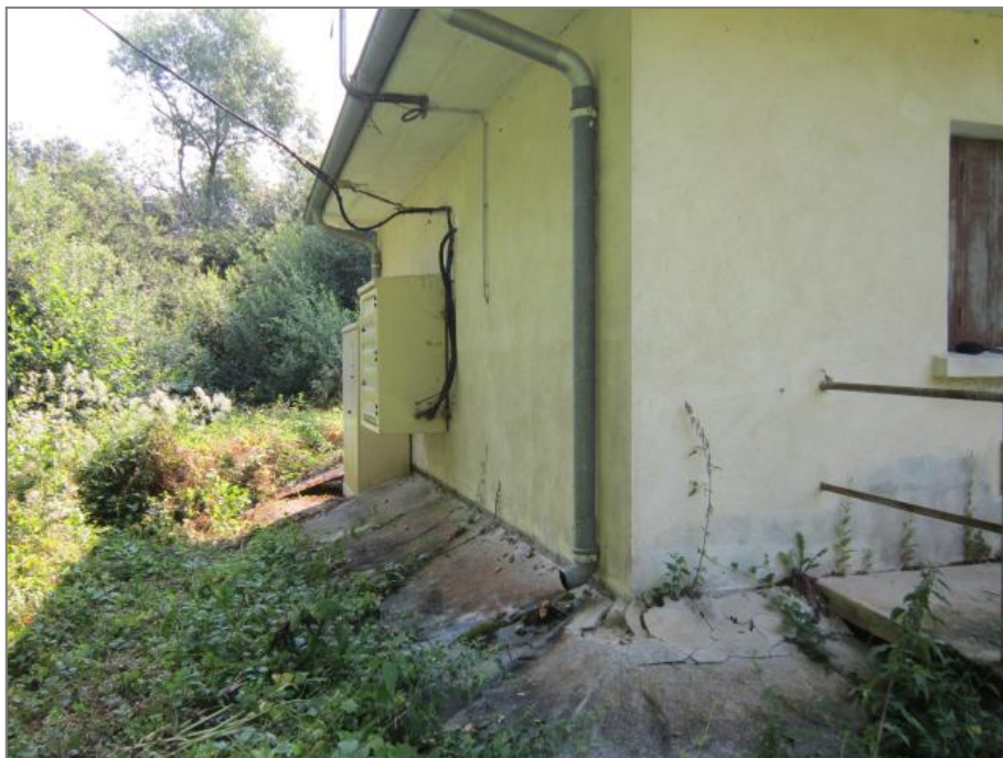
Figure 3 : Vue du « corroi » de béton autour du captage de la Source de Pranget
