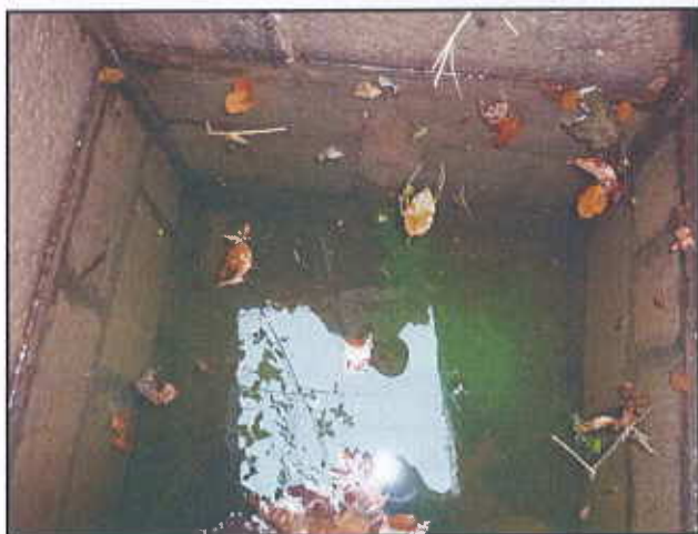
Colorant visible dans le drain inférieur de l'ouvrage de collecte "inférieur"
