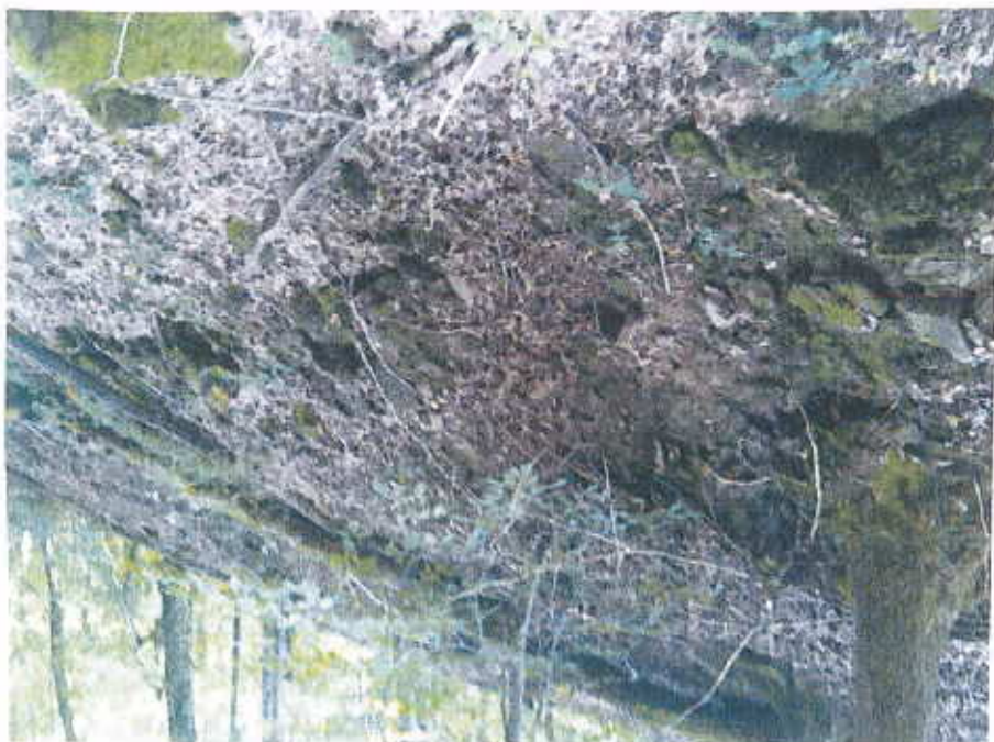
Talutage de l'ancien front par éboulement
