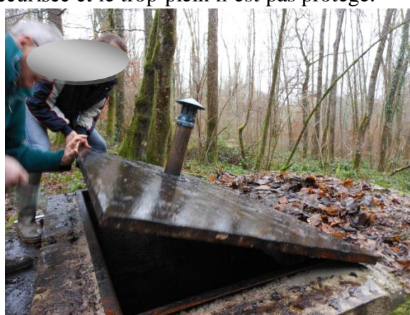
vues de la bêche de collecte du groupe des captages Clairs Chênes
