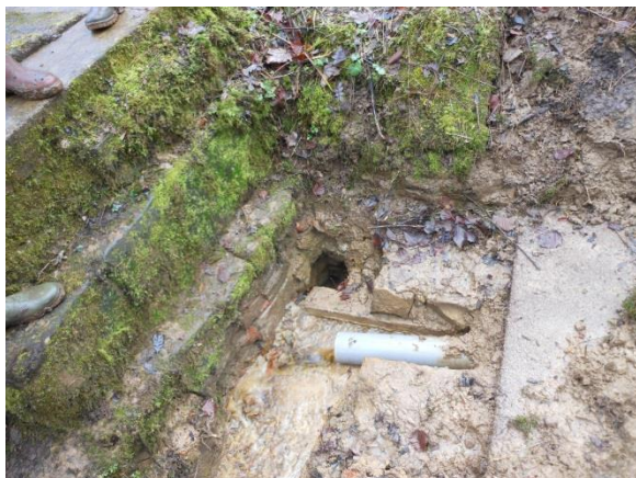
arrivée du tuyau plein du nouveau captage
