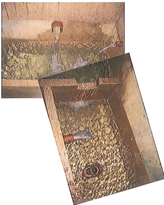
Figure 6 : Vue intérieure d'une partie du captage des sources de la Linotte n°2 (bac 1 et 2)
