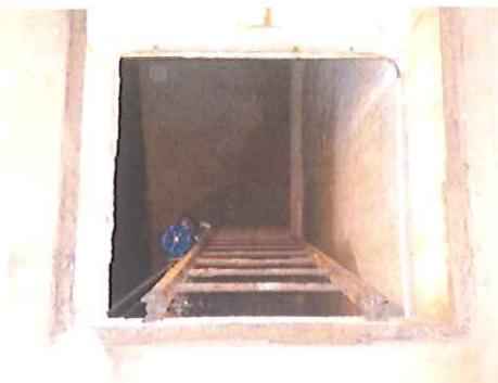
L'eau pénètre dans l'ouvrage par le fond et par 3 séries de 16 barbacanes percées à partir de - 4m et séparées de 1 m.
