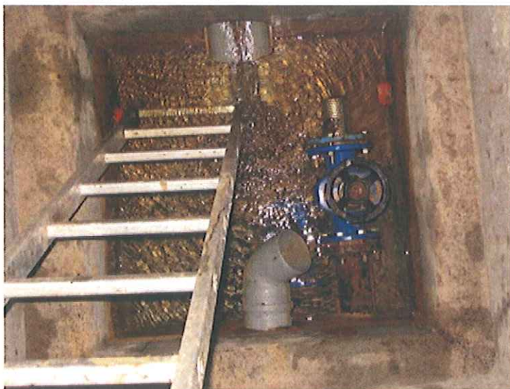
Figure 5 : Vue intérieure du captage de l'Étang
