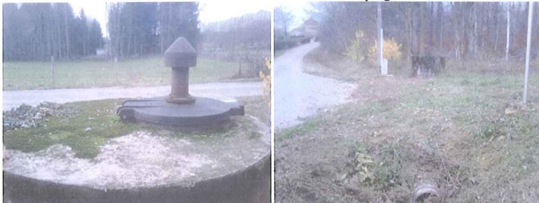
**Les risques inhérents aux ouvrages :** Le captage ne montre pas de signe de dégradation et son capot de fermeture est conforme à la production d'eau potable. Le forage dispose d'un abri assez rustique qui nécessite un entretien plus régulier et dont la fermeture est à améliorer. Le troisième ouvrage visible sur la parcelle communale est à neutraliser pour éviter tout transfert vers la nappe.
